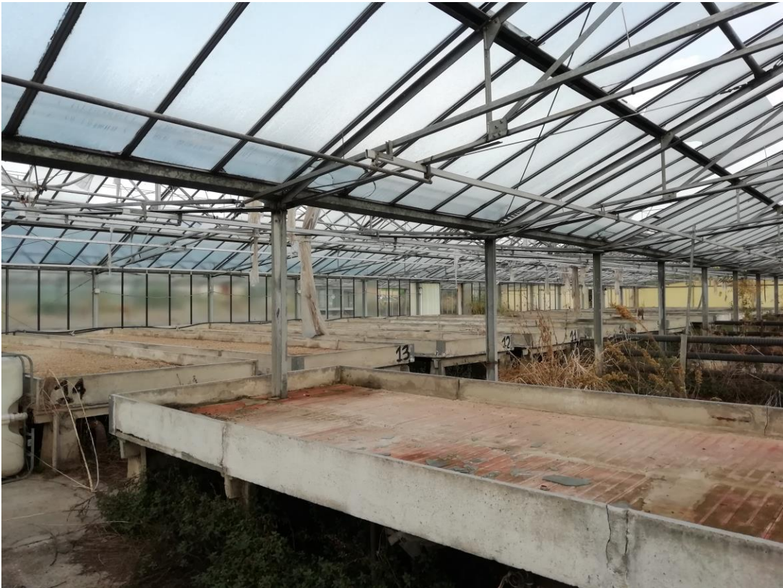
Interno delle serre esistenti nell'area da recuperare
