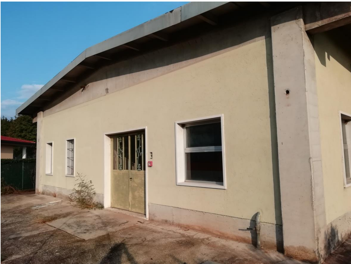
Il capannone esistente nell'area da recuperare
