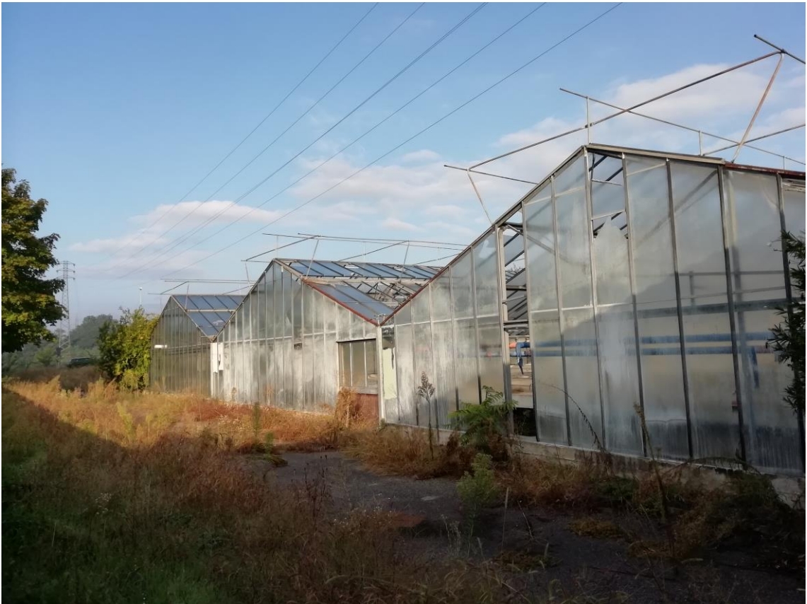
Le serre esistenti nell'area da recuperare
