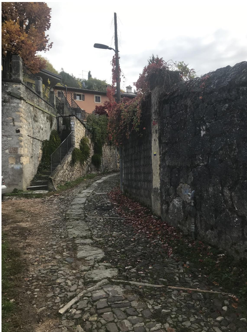
FOTO 13_Vista attuale via Sbusa – portone murato
