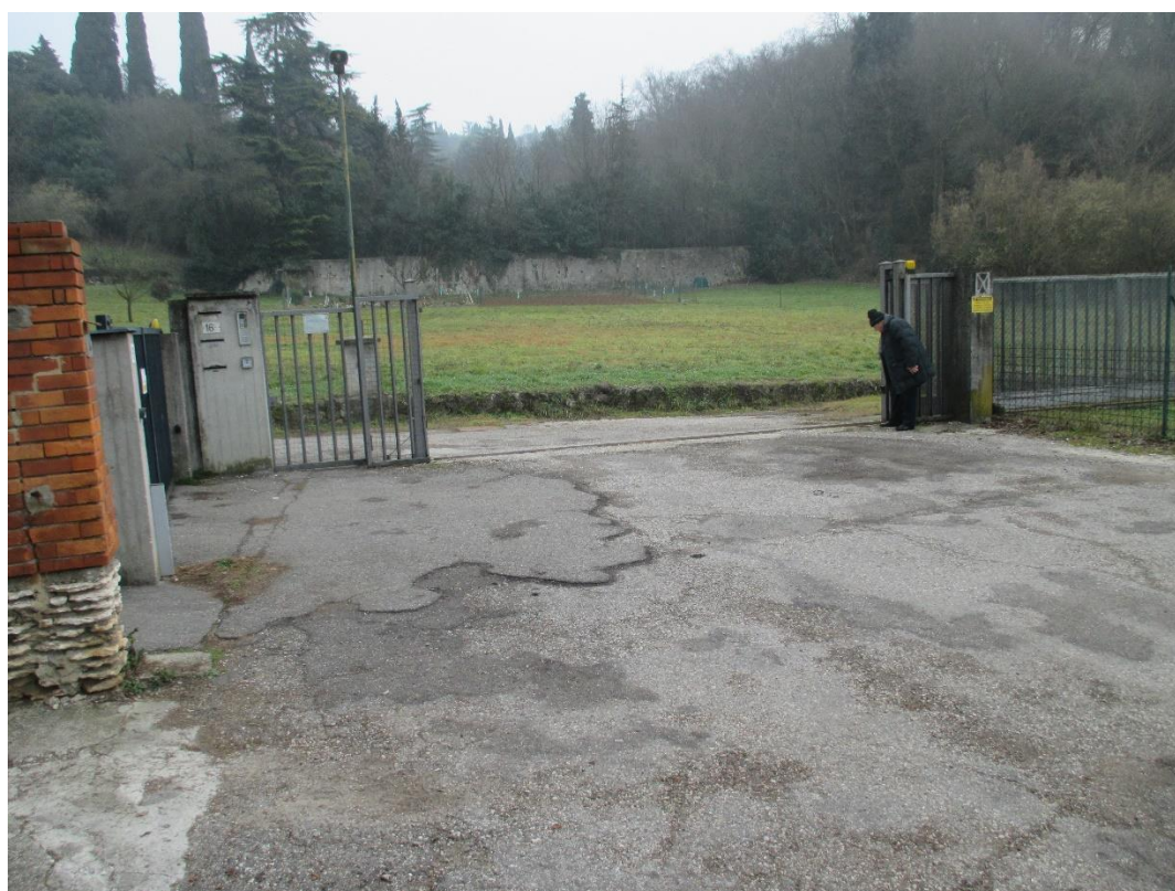
FOTO 4_Vista cancello entrata complesso residenziale esistente
