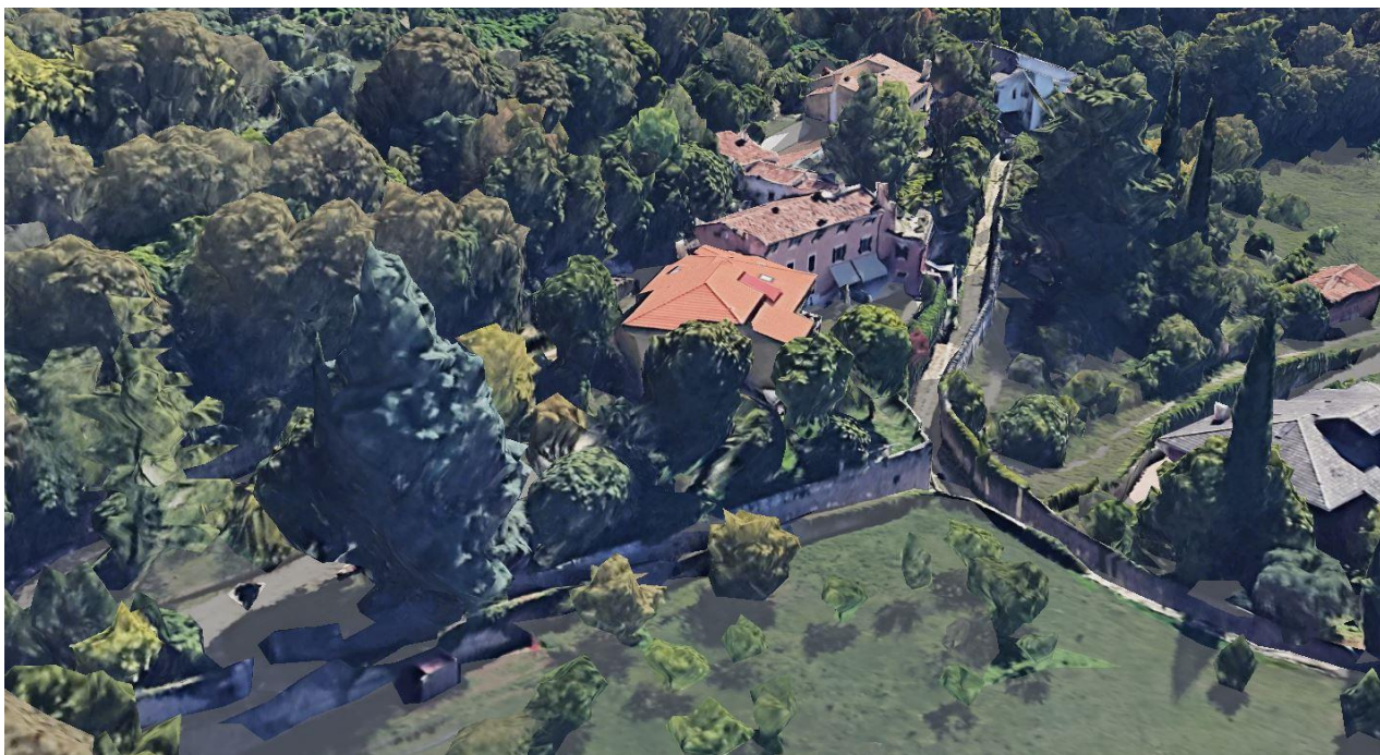
Immagine 8 -Vista lato Sud-Est opera di collegamento – Stato attuale
